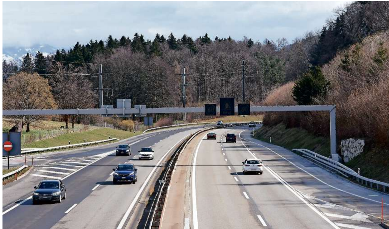
Anzeigetafeln und Kameras hängen an manchen Signalportalen bereits: so auch am neuen Portal in Altendorf. Bild Patrizia Baumgartner
